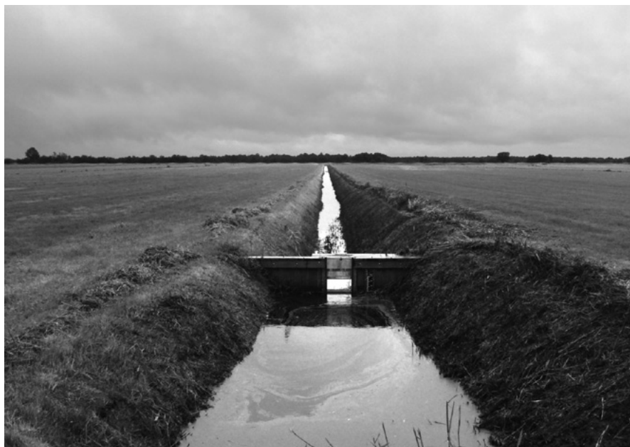
Met schuiven in een sloot kan het waterbeheer in de NOP verder worden verfijnd. (Bron: Loonbedrijf Knoppers.nl)
