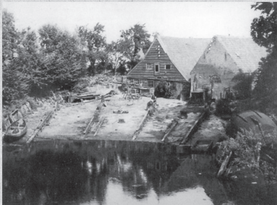
De Vollenhoofse scheepswerf van de Harlinger Jan Kroese, de vader van Barend. Hier werden sedert 1902 de bolletjes gebouwd, vissersscheepsjes die een kruising waren tussen de botter en de schokker. In 1904 bouwde Kroese in opdracht van Rijkswaterstaat een Vollenhoofse bol voor de lichtwachter van Kraggenburg (Foto J. Kroese, Heerenveen).
