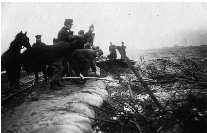
Fig. 15. Militairen en burgers leggen noodzeeweringen in de Anna Paulownapolder: zakken met klei en zand worden met aarde bedekt. www.geheugen.vannederland.nl
