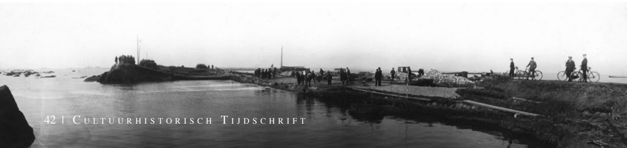
Fig. 20. Na de grote doorbraak liggen de zinkstukken klaar voor deze hulpdam. Fotoarchief- Hoogheemraadschap Hollands Noorderkwartier.
