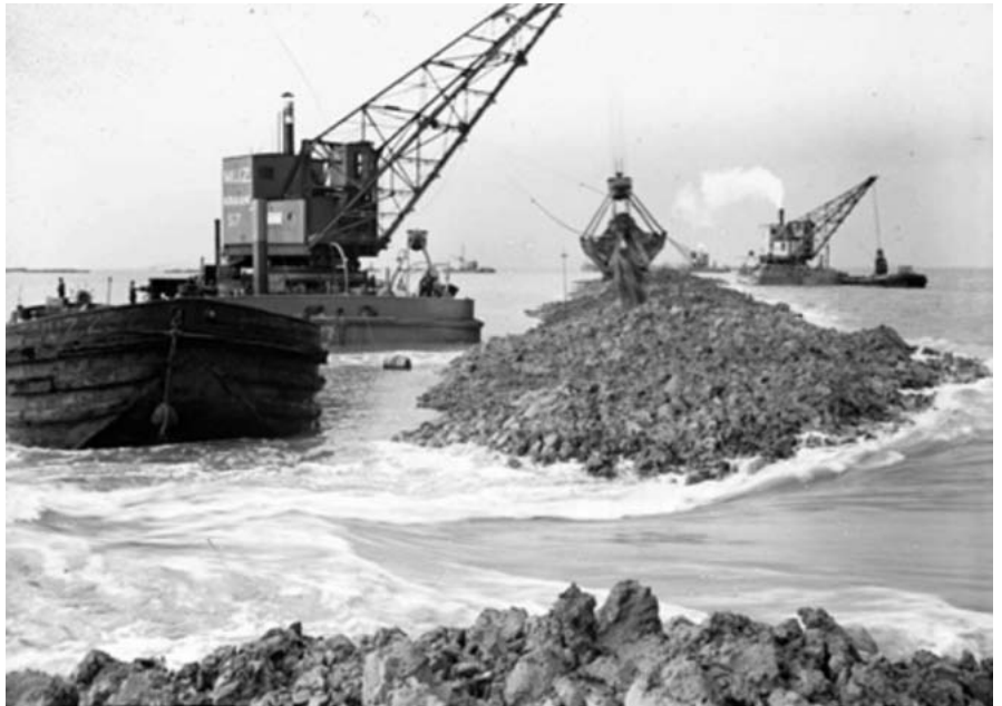
Aanleg van dijken dwars door zee.
