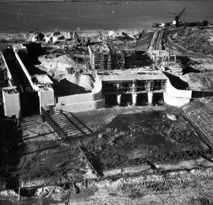
De aanleg van Gemaal Wortman bij Lelystad. Bron: beeldbank.rws.nl
