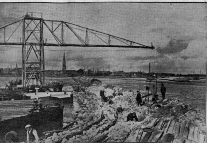
De werkzaamheden aan de inpoldering van de Noord-Oost polder bij Lemmer. Een overzicht van de aanleg van de kalfsemdam, voor de funderingsput met aansluitend opslagterrein, vanuit zee gezien. Op de achtergrond de toren van Lemmer.
