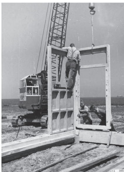
Impressie van de assemblage-werkzaamheden aan een boerderij van Schokbeton.
