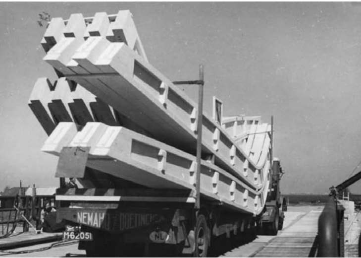
Transport van de houten knikspanten voor de bouw van een schuur van Schokbeton. Bron: www.emmeloord.info
