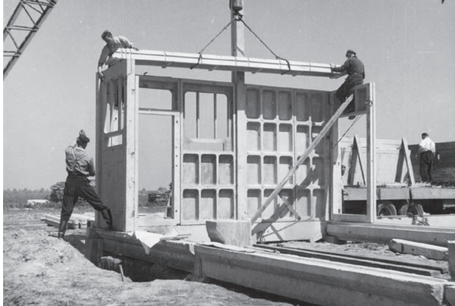
Impressie van de assemblage-werkzaamheden aan een boerderij van Schokbeton.
