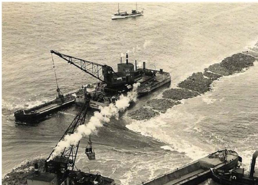
Luchtfoto van de aanleg van de Afsluitdijk. De dijk, die eigenlijk een dam is, was in 1932 klaar.
